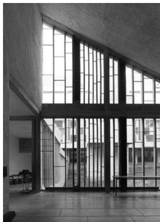
Couvent de la Tourette (1957-60) Le Corbusier. Plan ondulatoire entre l'église et le couvent. Parois vitrées segmentées de meneaux en béton réglés sur les rythmes syncopés des compositions musicales et mathématiques de Iannis Xenakis
